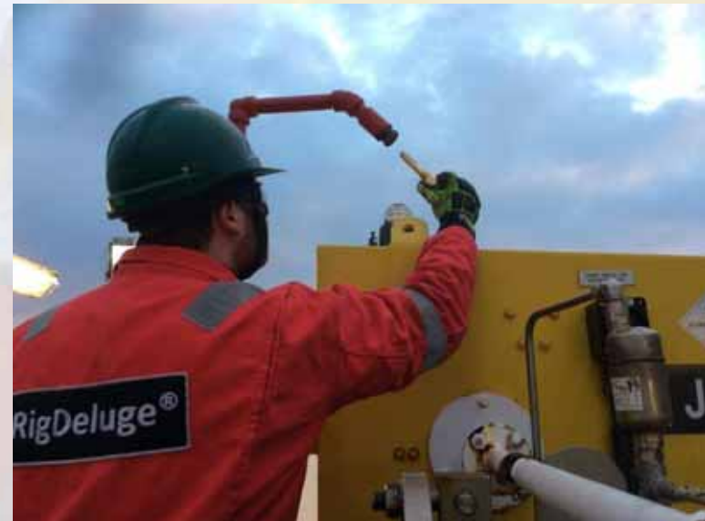
Install RigDeluge® CFT™ Adaptor
